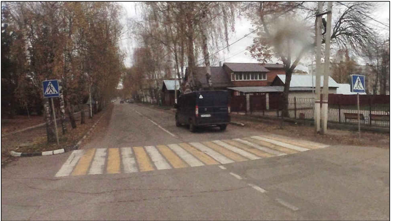
Рисунок 1.6.4 – Пример эксплуатационного состояния горизонтальной разметки 1.1, 1.7 и разметки 1.14.1 с желтым заполнением (обозначающей пешеходный переход) нанесённых в г. Юрьев-Польский по ул. Шибанкова
