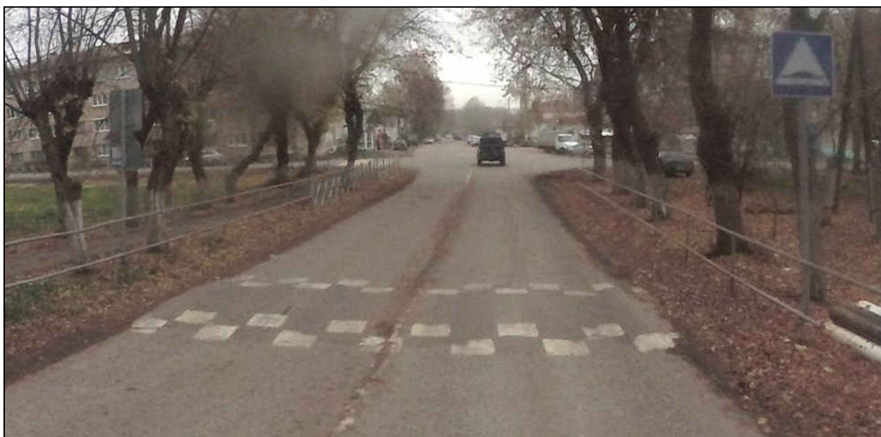
Рисунок 1.6.7 – Пример эксплуатационного состояния ИИ монолитной конструкции, расположенной в г. Юрьев-Польский, по ул. Горького
