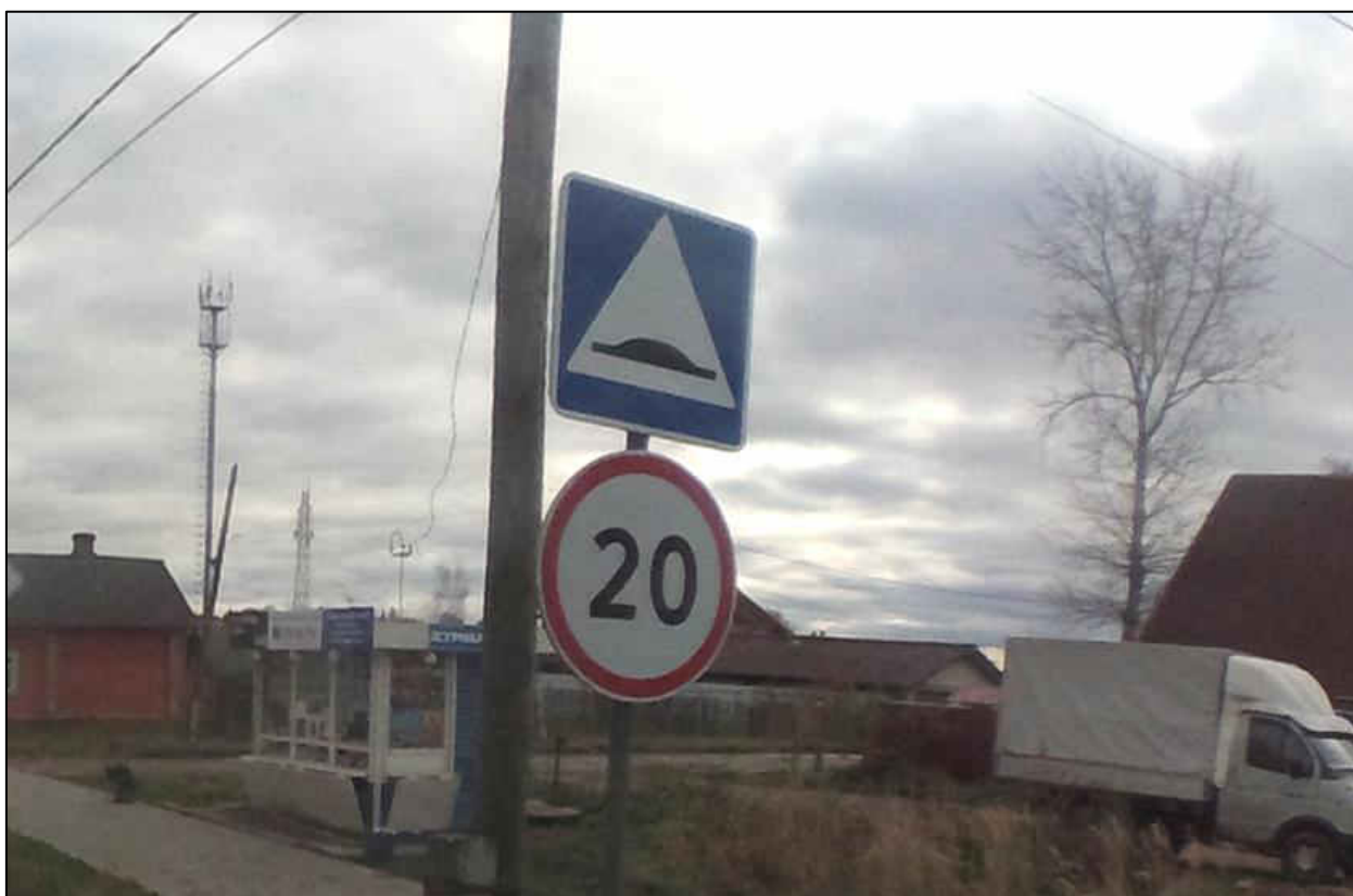
Рисунок 1.6.2 – Вид эксплуатационного состояния знака 5.20 «Искусственная неровность» и знака 3.24 «Ограничение максимальной скорости» расположенных в г. Юрьев-Польский по ул. Школьная
