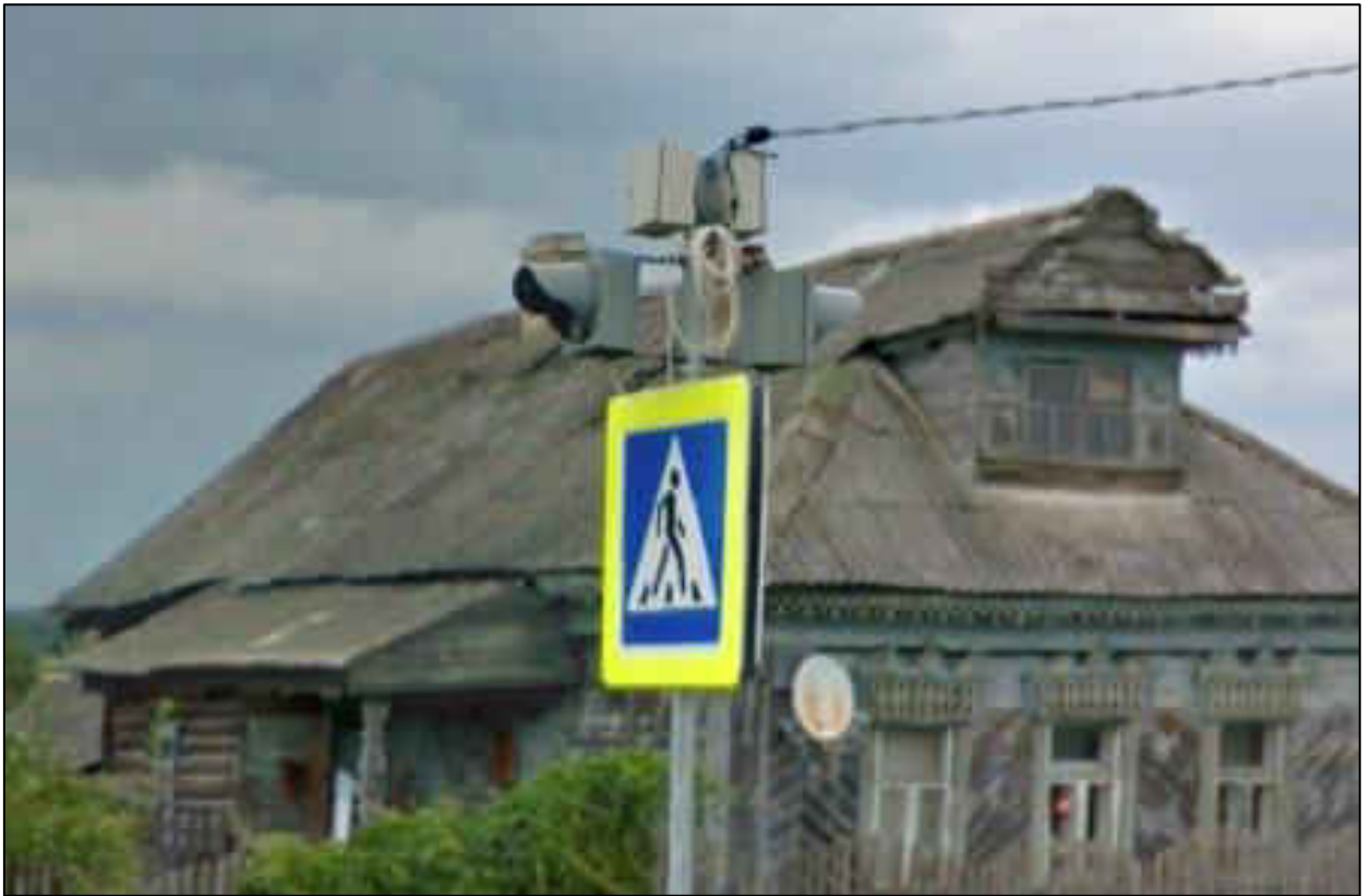
Рисунок 1.6.1 – Вид эксплуатационного состояния светофоров Т.7 расположенного в д. Марково на а/д 17 ОП РЗ 17А-1 «Владимир – Юрьев-Польский – Переславль-Залесский»
