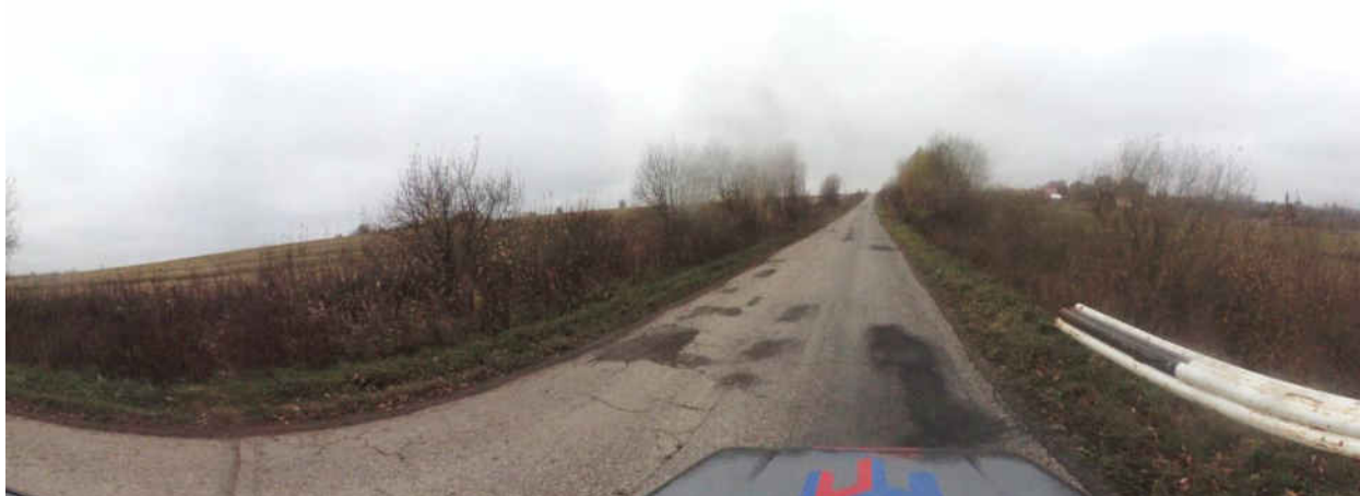
Рисунок 1.3.7 – Состояние дорожного покрытия а/д 17 ОП МЗ 17Н-752 Юрьев-Польский – Косинское на момент обследования
